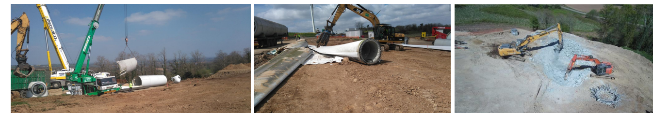
Figure 3 de démantèlement du parc éolien de Plouyé (démontage de l'éolienne, cisailage de la pale, destruction de la fondation)
